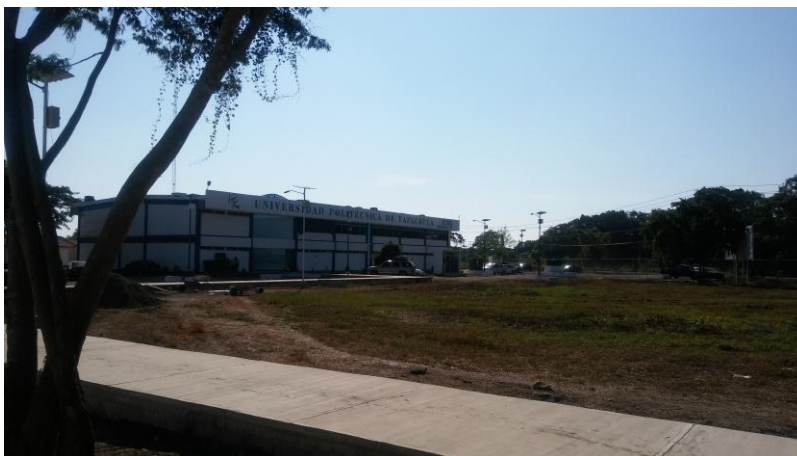
Vista de la colindancia con las instalaciones de la Unidad de Docencia Uno (UD1).
