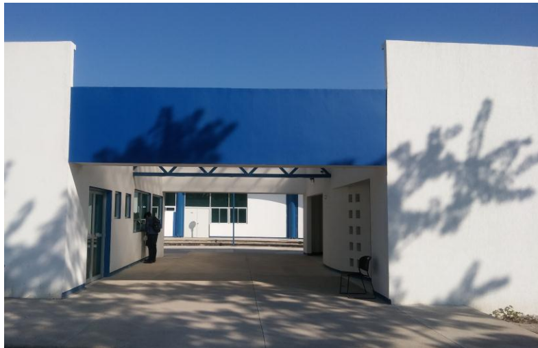
Vista Frontal de la entrada principal de las Instalaciones.
